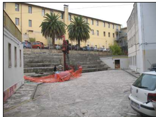
Foto n. 2: La foto mostra la sonda durante l'esecuzione d sondaggio geognostico n. 2, eseguito nel piazzale interno posto sul lato Nord-Ovest dell'edificio scolastico.
