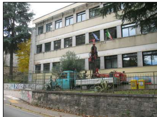
Foto n. 1: La foto mostra la sonda durante l'esecuzione del sondaggio geognostico n. 1, eseguito in corrispondenza di un'aiuola posta sul lato Sud-Est dell'edificio scolastico.
