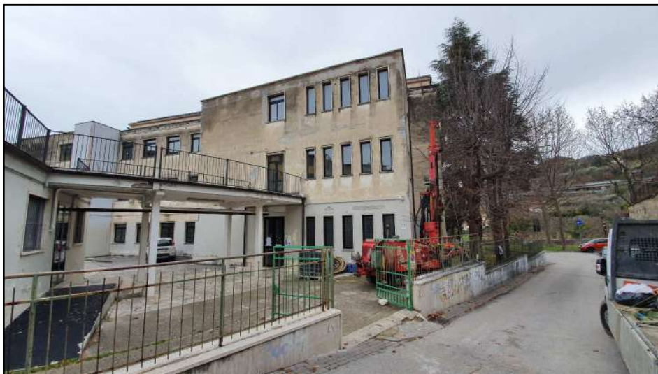
Foto 1: La foto presa da Nord mostra la sonda durante l'esecuzione del sondaggio geognostico S1
